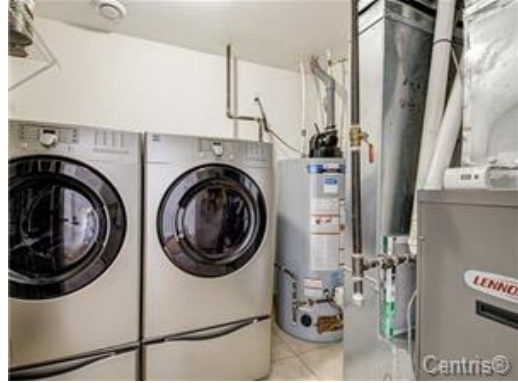
Salle de lavage
